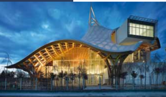
Chantier du Centre Pompidou-Metz, mars 2010, © Shigeru Ban Architects Europe et Jean de Gastines Architectes / Metz Métropole / Centre Pompidou-Metz, photo: Roland Halbe
